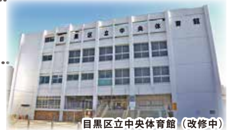
目黒区立中央体育館（改修中）
