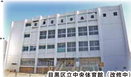
目黒区立中央体育館（改修中）
