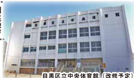
目黒区立中央体育館（改修予定）
