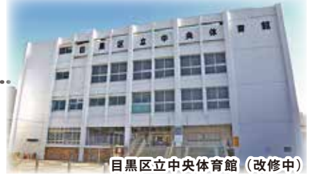
目黒区立中央体育館（改修中）
