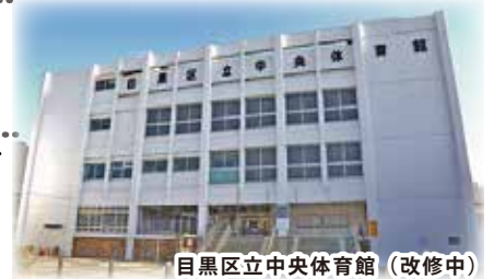
目黒区立中央体育館（改修中）
